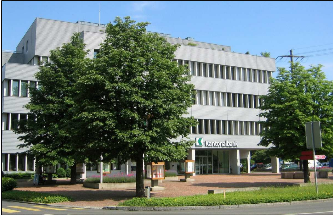
Aufnahme mit «rotem Platz», 2003, vor Baubeginn der Unterführung Wilerstrasse
