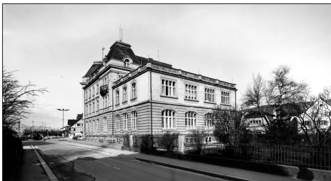
Büros auf der Ostseite des Hauptgebäudes, angebaut um 1930 (?), Aufnahme 1960er-Jahre.
