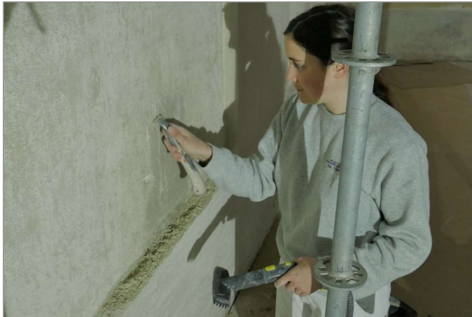
In mühseliger Kleinarbeit wird die 1990 aufgetragene Farbe mit Dampf entfernt.
