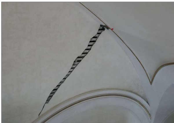
Grosse Risse gehen durch alle Putzaufbauten bis auf die Gipsperlättli.
