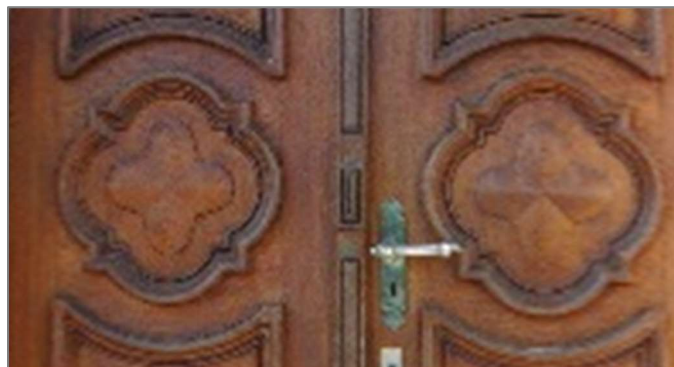
Das Ornament wird gleich wie in der bisherigen zweiflügeligen Türe gearbeitet.
