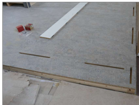
Im neuen Holzpodest sind die Schlitz für die Montage der Bänke eingefräst.
