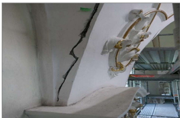
Grosse Risse gehen durch alle Putzaufbauten bis auf die Gipsperlättli.
