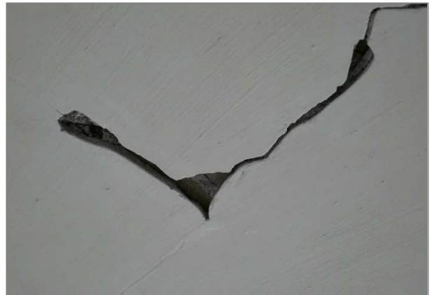
Grosse Risse gehen durch alle Putzaufbauten bis auf die Gipsperlättli.
