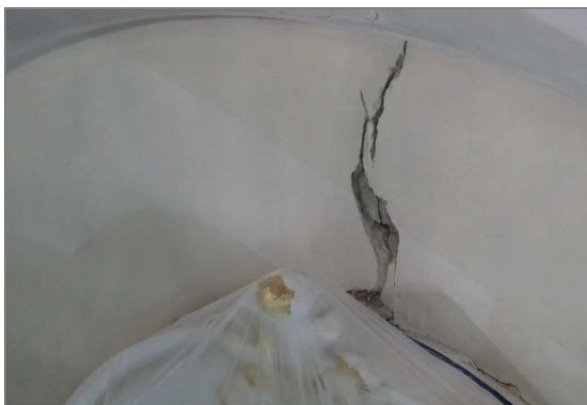
Grosse Risse gehen durch alle Putzaufbauten bis auf die Gipsperlättli.
