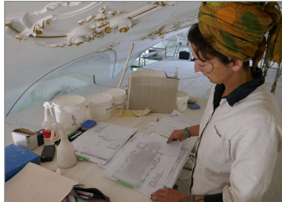
Plan mit dem Rissbild und Dokumentation der ausgeführten Massnahmen.
