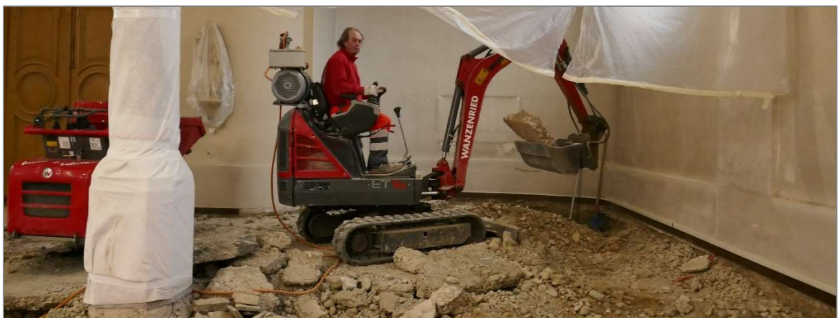
Mit dem Elektrobagger wird der gesamte Boden des Kirchenschiffes entfernt.
